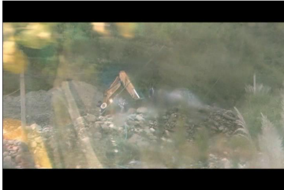
■ 坑口下流の川底をパワーショベルで掘り出し、その場で青空市場が開かれています
